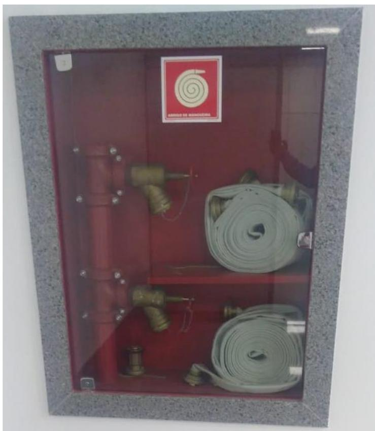
Fig. 22 – Detalhe da caixa de Hidrante de embutir
