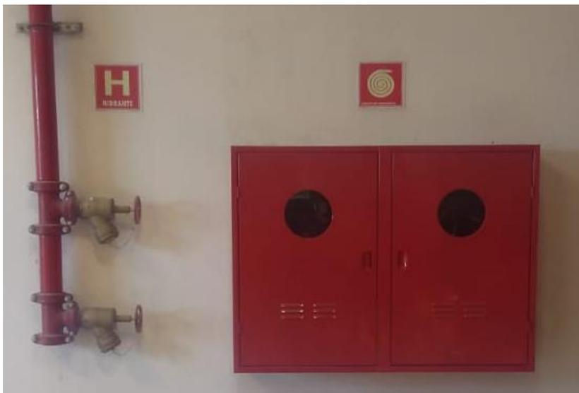
Fig. 23 – Detalhe da caixa de Hidrante de sobrepor
