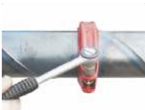
Fig. 14 – Detalhe de aperto da conexão em tubulação
