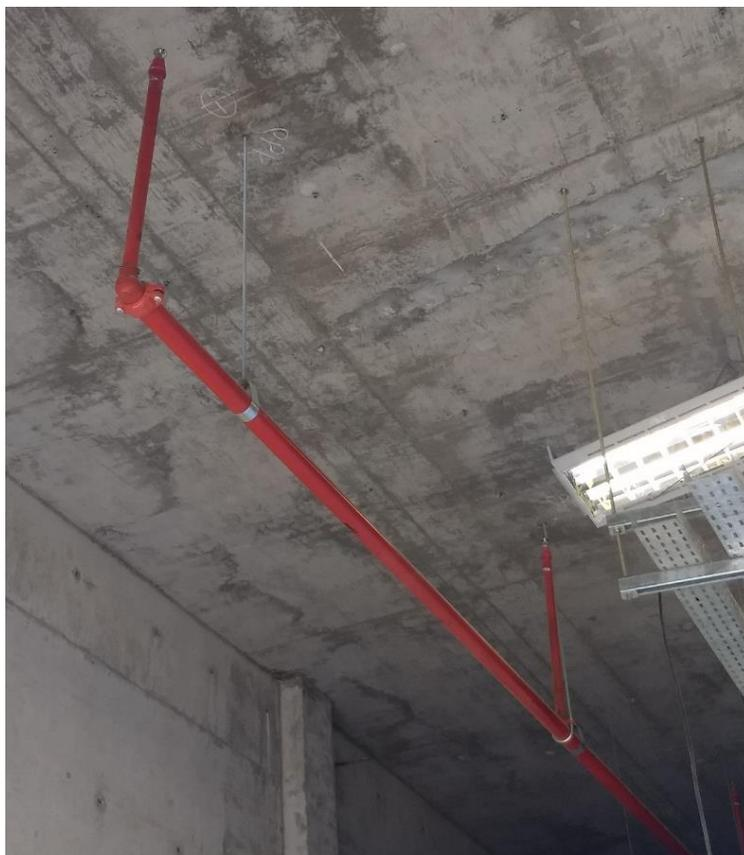
Fig. 16 – Detalhe de aplicação de canetas e bicos de Sprinkler
