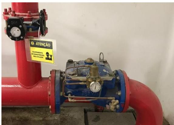
Fig. 05 – Válvula redutora de Pressão
