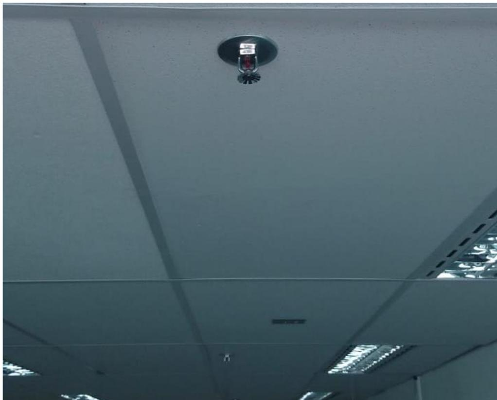
Fig. 18 – Detalhe de aplicação de Bico no forro
